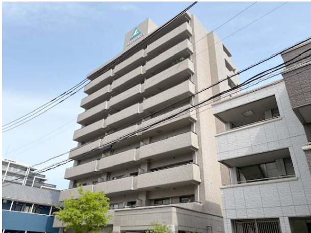
[外観・現況][外観写真]南向きのバルコニー
